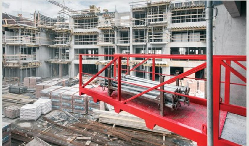
Tragfähigkeit 4 Tonnen, der Boden der Plattform entspricht der Deckenebene, was Ergonomie im Gebrauch gewährleistet.
