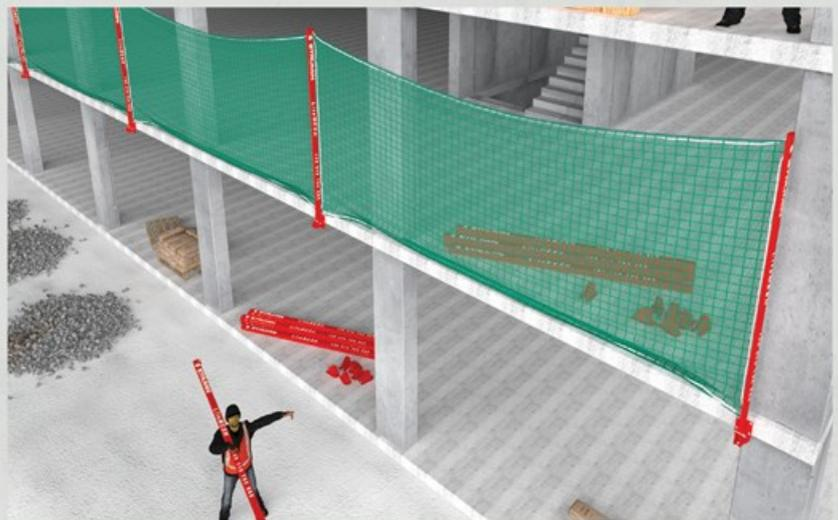
LiteMESH-Modul in Frontmontagekonfiguration.
