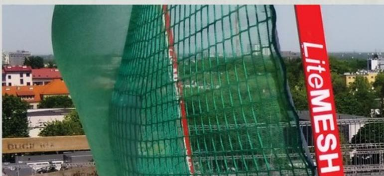
100x100 Netz, das den Fall von Objekten und Werkzeugen erfasst, Moskitonetz, das kleine Elemente abfängt.
